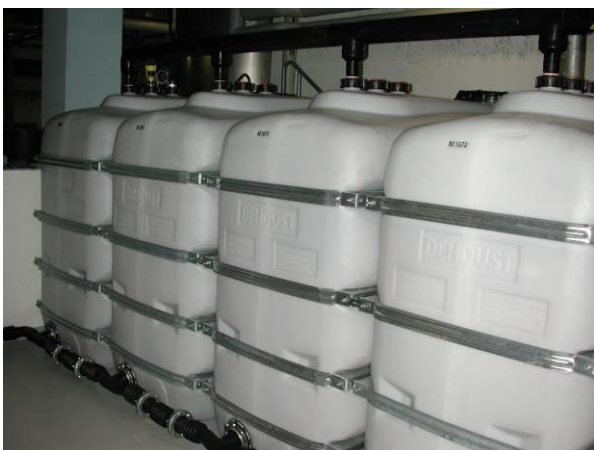
Vier neue PE-Tanks total 16m 3 Inhalt
