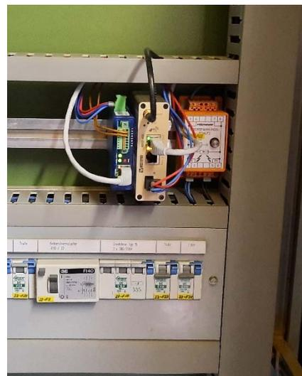
Aufgrund des Generationen- Wechsels in der Mobilfunktechnik musste in den Pumpwerken, sowie in der ARA Abländschen und Chalberhöni die Alarmübertragung erneuert werden. Durch die neue Technologie ist es auch hier möglich geworden, die Signale auf das Prozessleitsystem zu übertragen.
