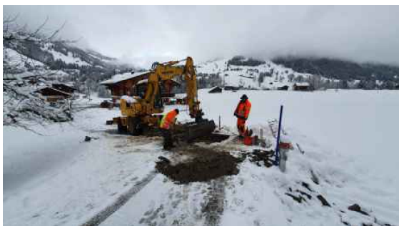
Nächtliche Reparatur eines Leitungsbruches Im Birkheimweg Schönried
