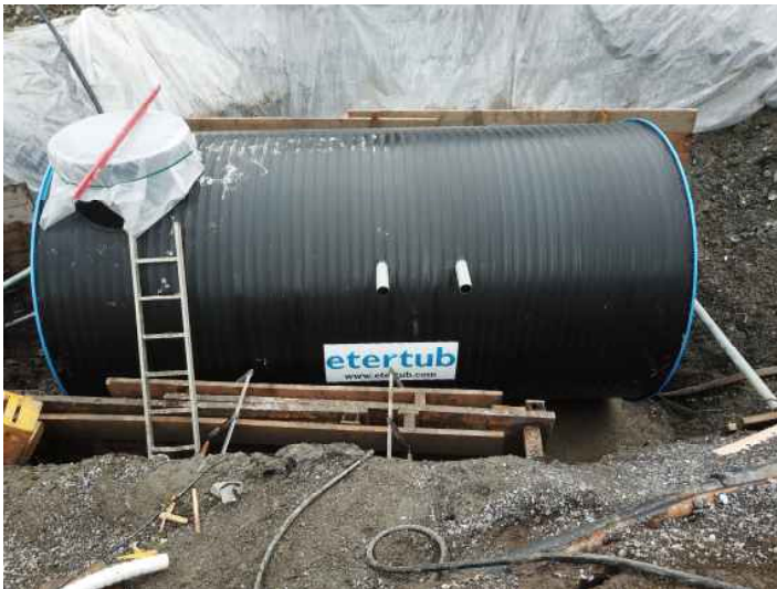
Setzen des Vorgefertigten Armaturenschacht aus monolytisch und doppelwandig PEHD von der Firma Etertub
