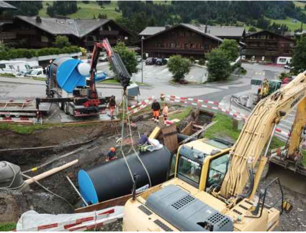
Setzen des Vorgefertigten Armaturenschacht aus monolytisch und doppelwandig PEHD von der Firma Etertub
