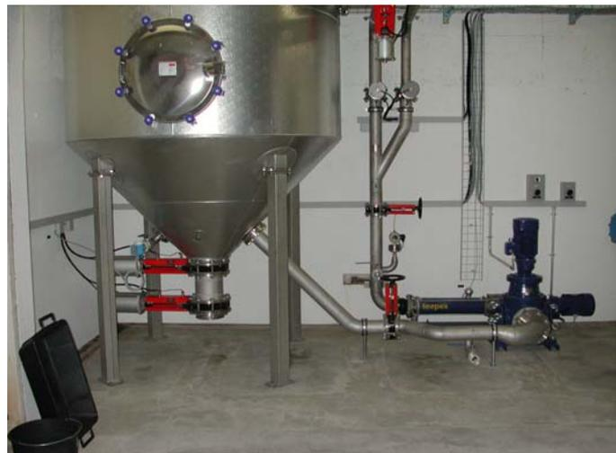
Speisereste aus den Gastronomiebetrieben des Saanenlandes und aus dem Obersimmental werden zu einer pumpfähigen Masse aufbereitet und auf der ARA mit dem eigenen Schlamm zusammen im Faulraum vergärt. Durch dieses zusätzliche organische Material kann die Gasproduktion markant gesteigert werden.
