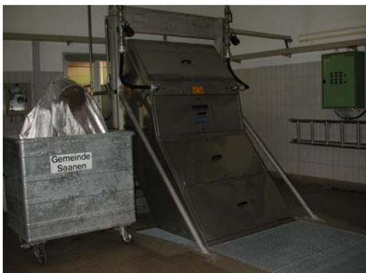
Der Feinrechen mit einem Stababstand von 3mm hält Grobstoffe zurück und fördert diese in die Rechengut-Waschpresse. In der Waschpresse wird das organische Material ausgewaschen und in den Zulauf zurückgeführt. Das gewaschene und gepresste Rechengut gelangt in einen Container und wird anschliessend der Kehrichtverbrennung zugeführt.
