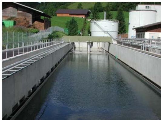
Das Schlamm-/Wassergemisch fliesst nach mehrstündigem Aufenthalt in den Belüftungsbecken in die Nachklärung. Dort findet eine Abtrennung des gereinigten Abwassers vom Belebtschlamm statt. Das gereinigte Wasser fliesst über Überfallrinnen in die Saane und der Belebtschlamm sinkt auf den Beckenboden, von wo er mit dem Saugräumer wieder zurück in die Anox-Becken gepumpt wird.
