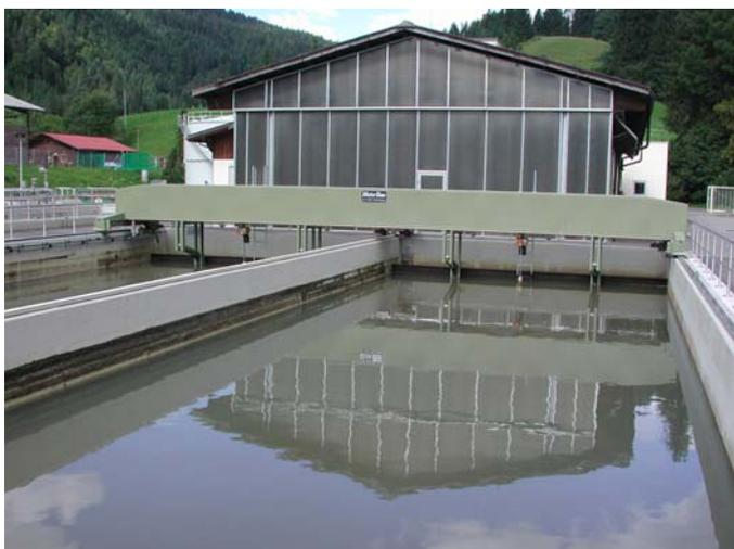
In der letzten Verfahrensstufe der mechanischen Reinigung sinken die noch vorhandenen, absetzbaren Schmutzstoffe auf die Beckensohle, von wo sie periodisch mit dem Räumerschild in die Schlammtrichter geschoben werden. Dort erfolgt eine erste statische Eindickung. Von da wird der Schlamm über den Frischschlammtrichter der weiteren Schlammbehandlung zugeführt. Der noch in geringen Mengen vorhandene Schwimmschlamm wird ebenfalls von einem Schild an der Räumbrücke in den Schlammtrichter geschoben.
