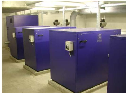
Das vorwiegend von menschlichen und tierischen Ausscheidungen herführende Ammonium im Abwasser ist für Fische giftig. Die Umwandlung dieser Stickstoffverbindung erfolgt durch spezielle Mikroorganismen im Belüftungsbecken. Dieser Vorgang wird Nitrifikation genannt und ist zwingend an genügend Luftsauerstoff im Abwasser gebunden. Aus diesem Grunde wird das Abwasser-/Belebtschlammgemisch künstlich belüftet. Neben der Nitrifikation werden gleichzeitig die organischen Schmutzstoffe abgebaut.
