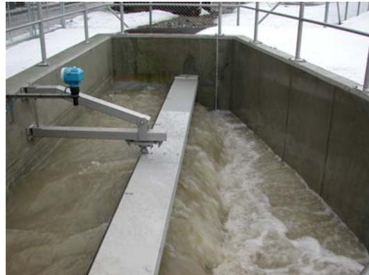
Das Regenbecken weist einen Inhalt von 400 m<sup>3</sup> auf. Es ist ausgerüstet mit zwei Entleerungspumpen und einem Air-Jet für die Beckenreinigung.
