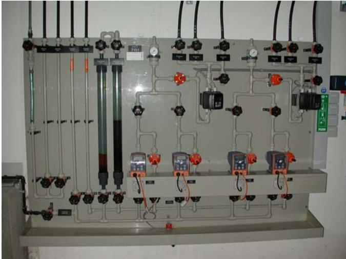
Phosphat wird der Kläranlage in gelöster Form zugeleitet und ist im Gewässer ein unerwünschter Dünger. Um das Phosphat aus dem Abwasser zu entfernen, muss ein Fällmittel (Eisenchlorid) in die Biologie zudosiert werden. Der entstehende Fällungsschlamm wird mit dem Belebtschlamm vermischt und mit diesem aus dem Abwasser entfernt.
