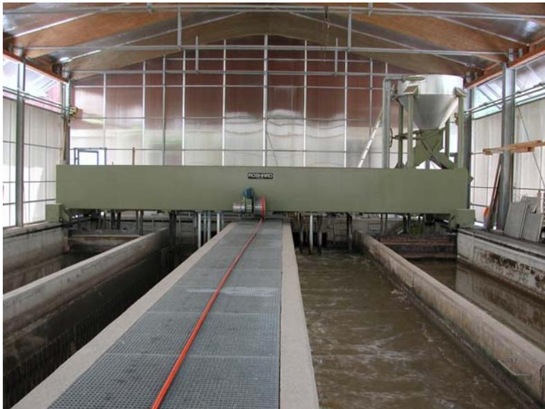
Abwasser führt insbesondere bei Regenwetter ansehnliche Mengen von Sand mit, welcher sich nachteilig auf die nachgeschalteten technischen Ausrüstungen auswirkt. Sand und ähnliche Partikel werden aus diesem Grunde im belüfteten Längsandfang vom Abwasser getrennt. Die abgesetzten Sandpartikel werden mit dem Räumbrücke abgepumpt und in einen Container zur Entsorgung befördert. Damit die leichteren, für die weitere Abwasserreinigung wichtigen Bestandteile in Schwebelage bleiben, wird Luft
