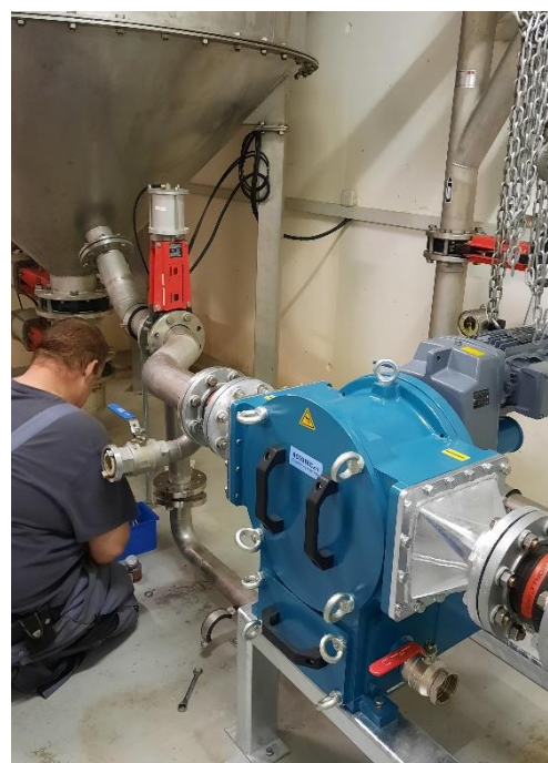
Montage und Verrohrung
