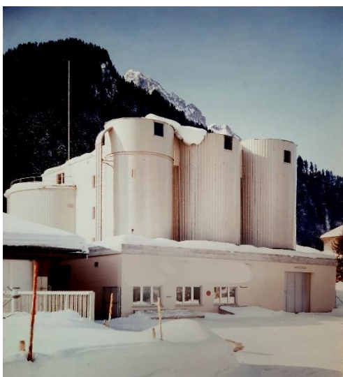
1984 bis 2002 Schlammbehandlung mit Rottesilos
