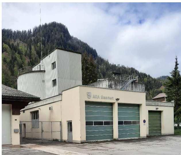
Ansicht heute mit Anbau Schlammmuldenhalle
