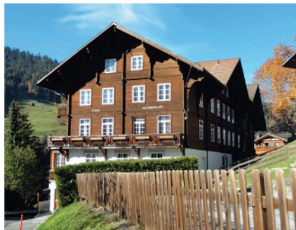
Abb. 3 Eines Institutsgebäude auf dem Riedhubel mit Erneuerungsbedarf.
