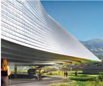
Abb. 39 Materialisierung der Konzerthalle mit hellen Photovoltaik-Schindeln (Quelle: Präsentation Herzog & de Meuron)
