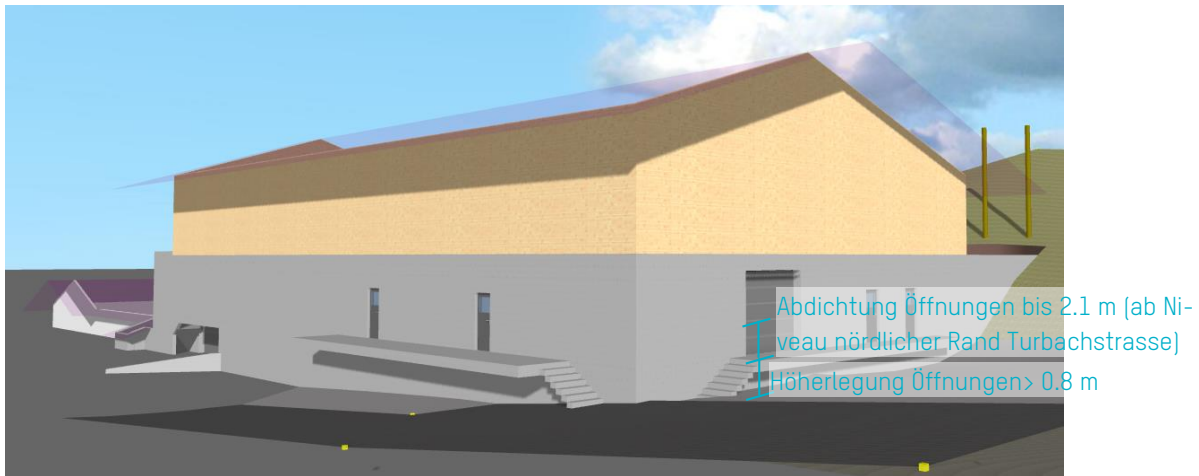
Abbildung 11: Schutzmassnahmen Überschwemmung/Übersarung Neubau Parzelle 571, Fassade Ost.
