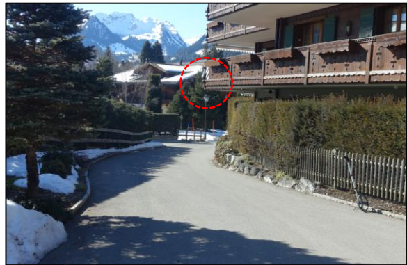
Abb. 4: Eingeschränktes Lichtraumprofil «Parkstrasse 11» mit schwarz-weißer Leittafel
