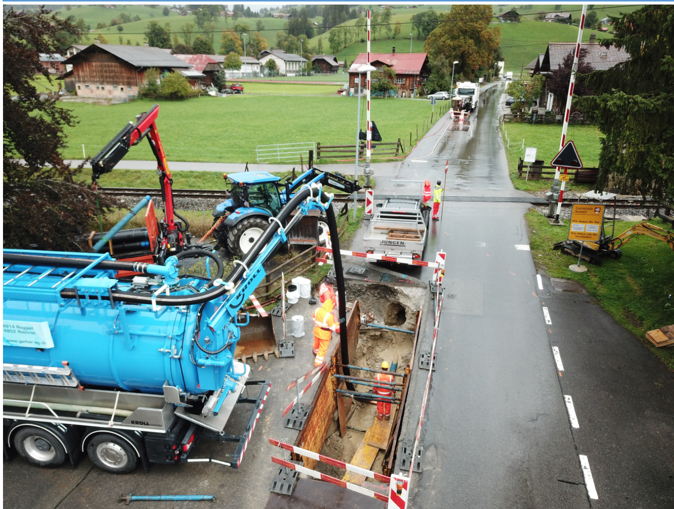
Leitungserneuerung Bellerivestrasse Bohrung unter MOB
