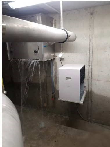
Überflutung eines Grundwasserwerkes aufgrund Starkregen 23 auf 24. Dezember 2022 Regenfall in 24 Std. 50,50 l/m 2
