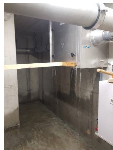
Überflutung eines Grundwasserwerkes aufgrund Starkregen 23 auf 24. Dezember 2022 Regenfall in 24 Std. 50,50 l/m 2
