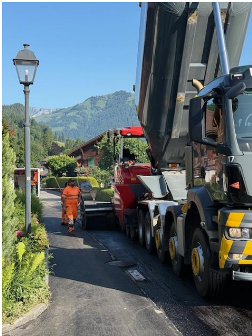
Belag Einbau Gschwendstrasse
